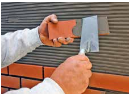
StoBrick liimataan suoraan verkotuslaastin päälle ja saumataan.
