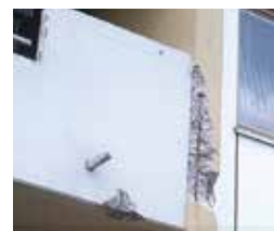
Vaurioitunut parvekkeseinä
