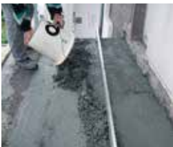
Polymeerisementtilaastin PCC levitys tuoreen tartuntalaastin päälle (märkää märälle)
