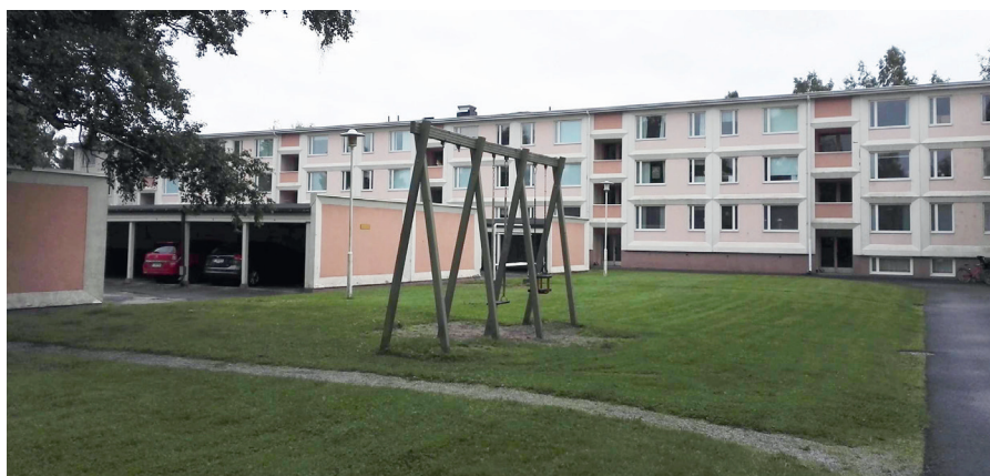
As Oy Pirkan Pirttien julkisivuissa oli perinteinen betonisandwich-rakenne, mutta ulkokuoressa erikoisempi kulmikas muoto. Kuva Eija Teivas Sitowise Oy.
