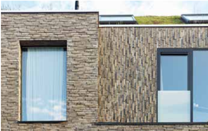
StoBrick liimataan suoraan alustalle ja näin saadaan täysin uusia mahdollisuuksia julkisivujen suunnitteluun toiveiden mukaan, rakenteellisista vaatimuksista huolimatta. Kuva: Asuintalo, BE-Gent.
